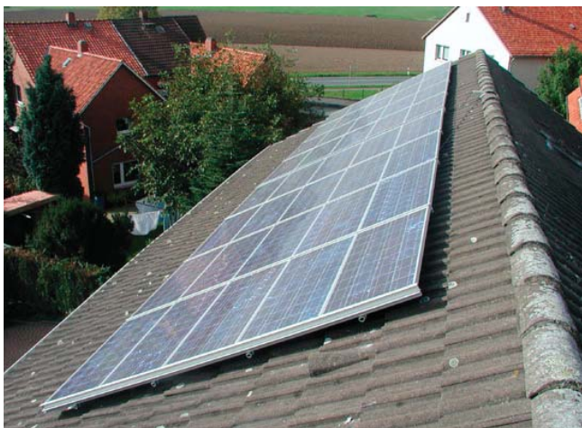
Монтаж солнечных панелей Naps Solar Roof является простым и легким, и подходит для любого вида кровли. Выше: солнечные панели на 1,5 кВт пик и 3 кВт пик на черепичной крыше.
